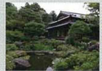
写真：有効活用されていない吉城園主棟
