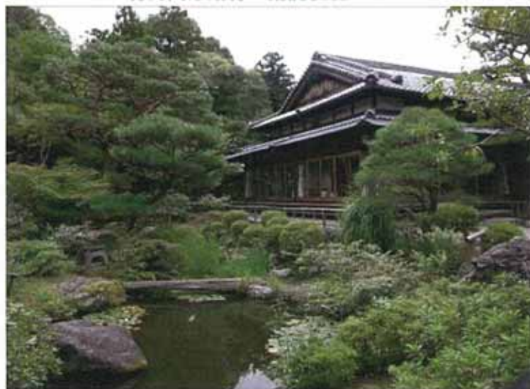
吉城園の状況（吉城園主棟の老朽化）
