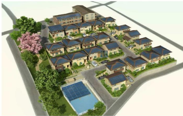
中部エリア初の戸建て住宅間の電力融通を実施
