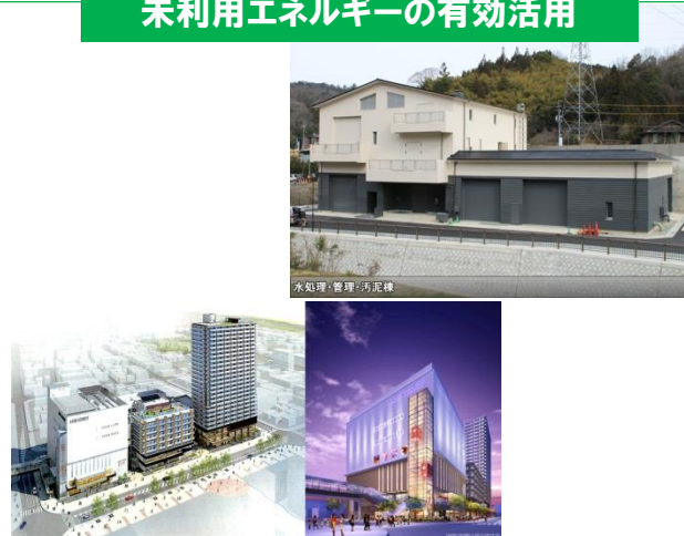
下水熱利用空調システム導入施設
