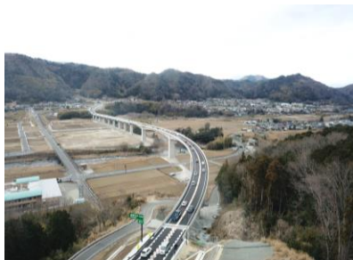
東西軸、南北軸を形成する高規格幹線道路の着実な整備(伊豆縦貫自動車道の整備)
