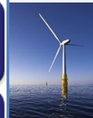
浮体式 洋上風車
