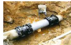
漏水防止のための整備
