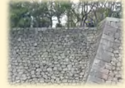
特別史跡「大坂城跡」の石積測量（大阪府大阪市）
