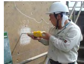
老朽化した施設の機能診断
