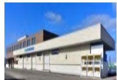
集出荷・貯蔵・加工施設の整備
