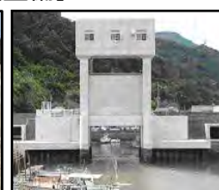
津波・高潮対策としての水門整備
