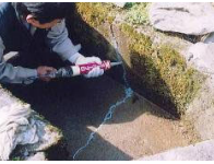
水路のひび割れ補修
