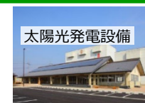
太陽光発電設備
