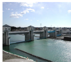
頭首工の改修
