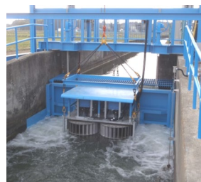
小水力発電施設の設置
