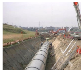
水路のパイプライン化
