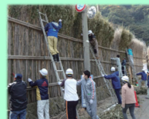
住民参加による修理 (石川県輪島市)
