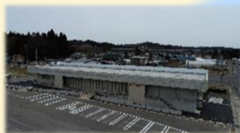
史跡「大平山元遺跡」のガイドン施設整備（青森県外ヶ浜町）
