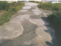
農道の窪みの補修
