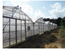
【農業用ハウスの整備】
