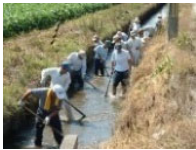
水路の泥上げ
