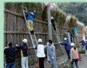
住民参加による修理 (石川県輪島市)
