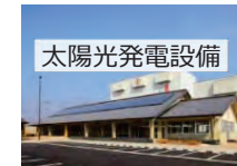
太陽光発電設備
