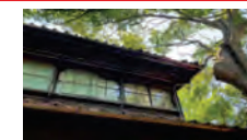
(建造物の修理)
