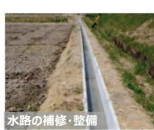
【簡易な基盤整備】
