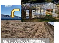
【荒廃農地の支障物撤去】
