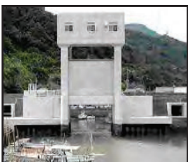
津波・高潮対策としての水門整備
