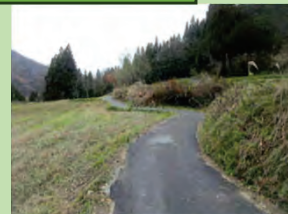
農作業道の舗装
