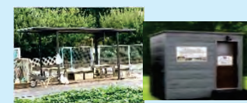
休憩所、トイレの整備
