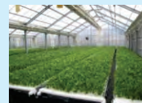
農業生産施設(水耕栽培ハウス)
