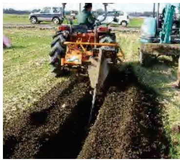
暗渠排水の整備
