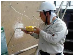
老朽化した施設の機能診断
