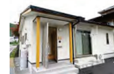
空き家の改修（お試し居住施設）
