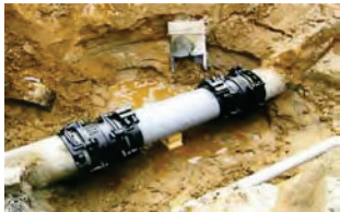
漏水防止のための整備
