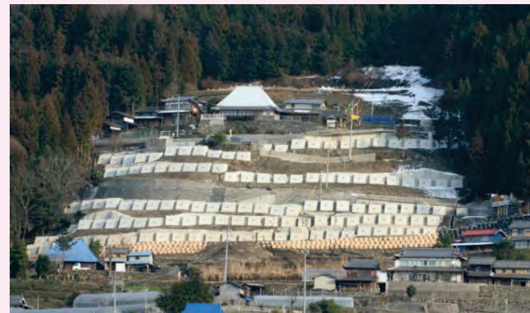
倉石地区(徳島県三好市井川町)
