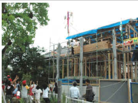
「産直住宅 上棟」
