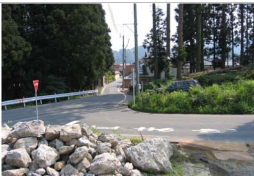
町道津川弘川線と広域農道東蒲原地区との交差点。営農団地からの農産物流通の高速化を図る。
