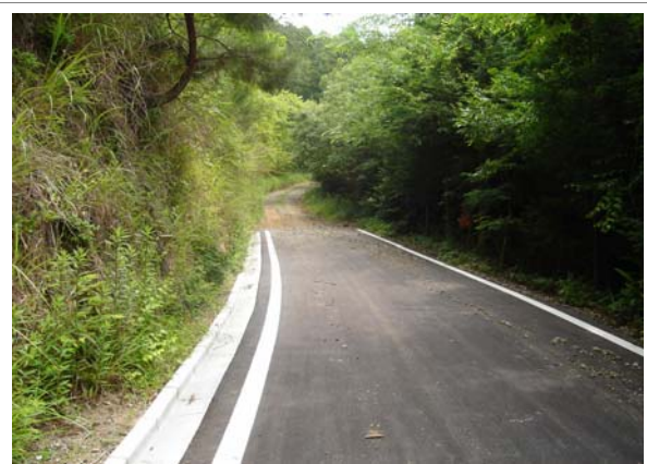
林道の舗装化
