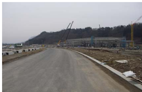
道路整備と隣接する企業工場建設
