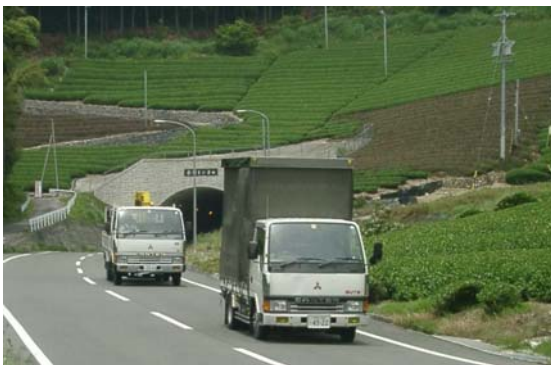
農道の整備により農産物の流通を改善
