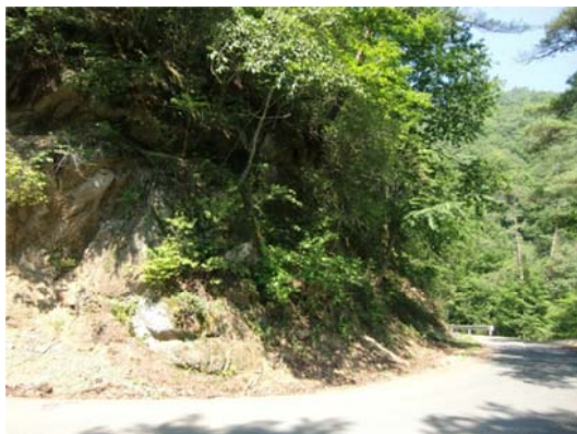
村道 10 号 万古川線 漆平野地区 工事前
