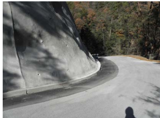
村道 10 号 万古川線 漆平野地区 防災工事
