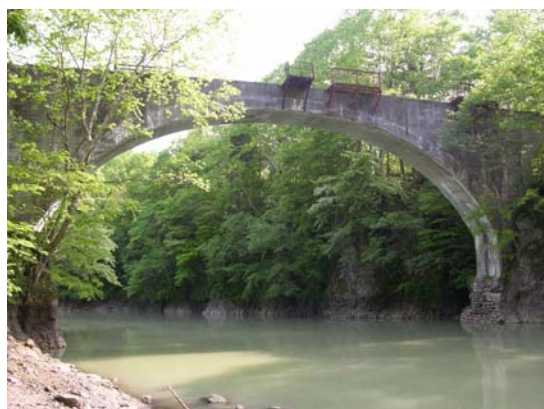
第三音更川橋梁
