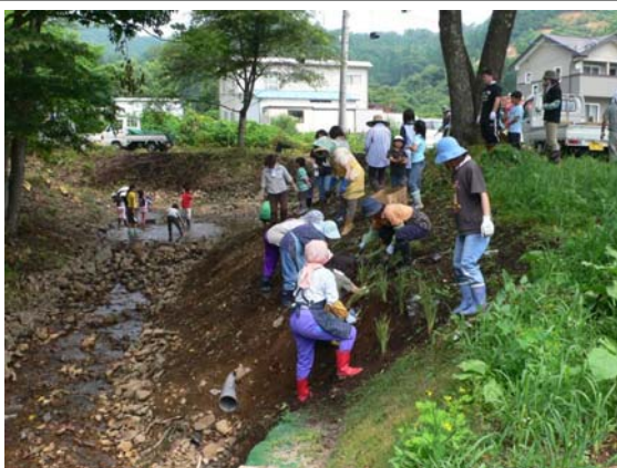
大沢まちづくり委員会による水路整備
