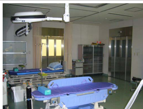
緊急処置室（市立敦賀病院）
