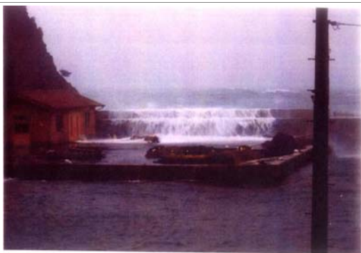
沖泊漁港（護岸越波による被害）
