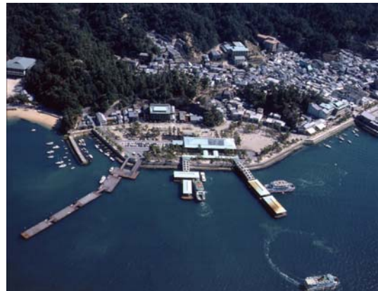
厳島港 宮島棧橋
