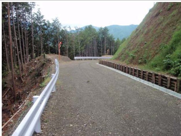
整備された林道
