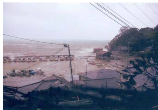
平成 16 年台風 23 号における 防波堤越波状況
