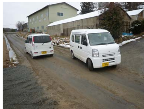
狭小な既存市道原線
