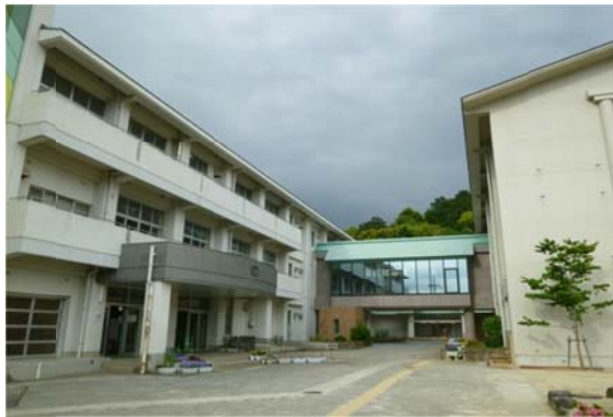
橋本市立 境原小学校校舎
