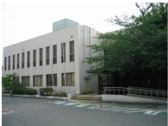
旧保健所跡を活用した新たな子育て支援施設
