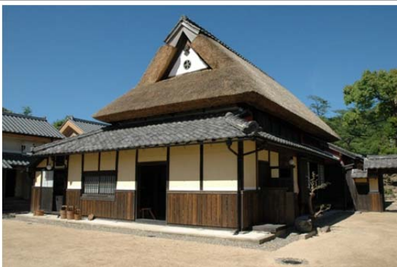
農村地域の交流拠点施設として再生された「大庄屋 上野家」
