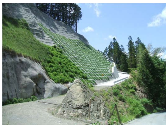
半納城峰線 (崩落法面の復旧)
