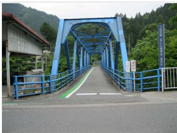
市道大滝 127 号線 (起点部分にかかる狭い既存の橋)
