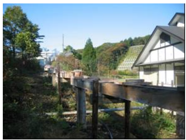
公衆浴場に木製の桶を使い温泉を供給している（しんとろの湯）
