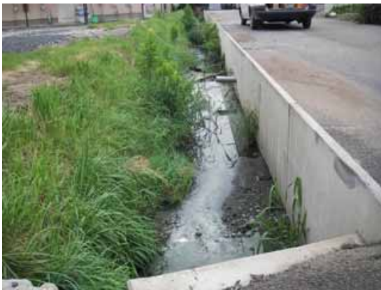
生活雑排水が流れ込む水路
