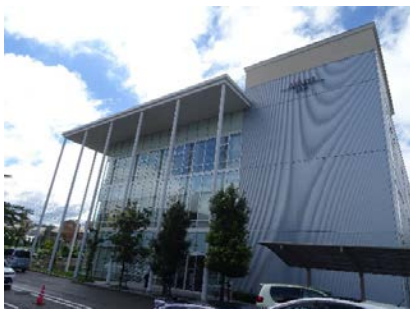
ICTの拠点 塩尻インキュベーションプラザ
