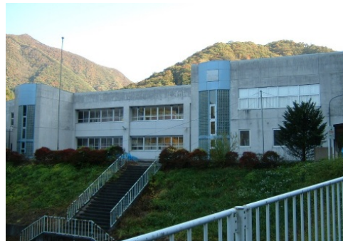
訓練校として活用する旧南郷小学校校舎
