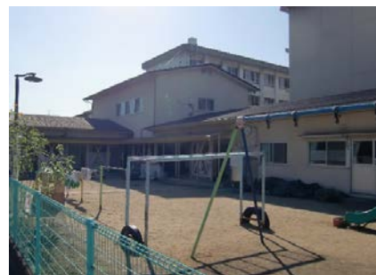
必要な耐震性能を有さない「現在の余土保育園」
