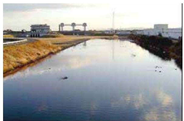
五間堀川分水路
