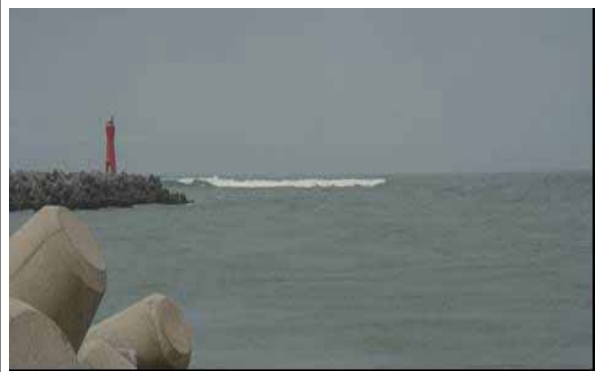
今切口沖合いの浅瀬の影響により発生した碎波
