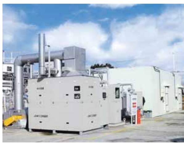
水素エネルギーを利用した省エネルギー型冷凍機
