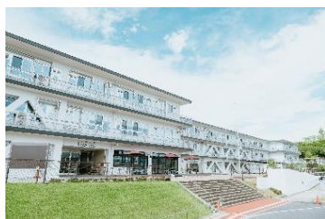
多世代交流拠点施設の外観
