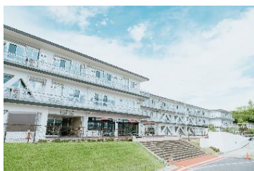
多世代交流拠点施設の外観
