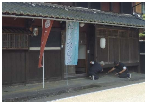
床下インスペクションの総合調査
