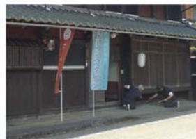
床下インスペクションの総合調査
