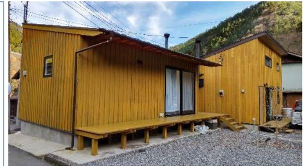
仮設住宅の部材を用いて「RE:ハウス」された住宅
