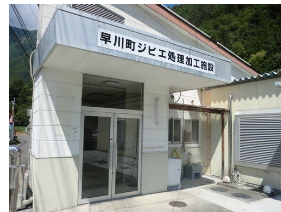
ジビエ処理加工施設
