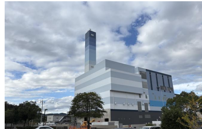
▲ 熱供給元となる新ごみ焼却施設
