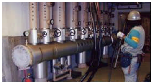
電気工事士の作業風景
