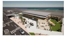
太陽光発電設備設置事業
