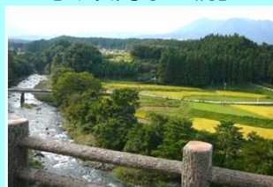
【那須高原大橋】
