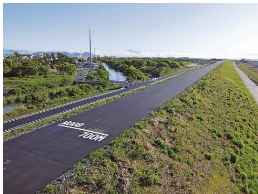
高さ11.8mの海岸防潮堤（整備済区間）
