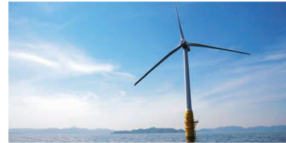
浮体式洋上風力（五島市崎山沖）
