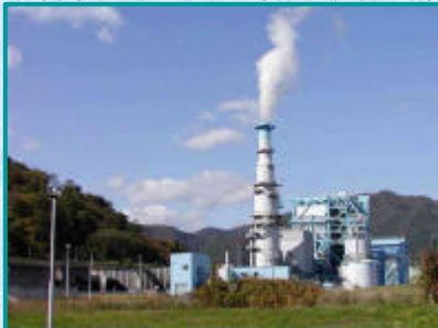
【新日本製鐵㈱の P P 石炭火力発電所】
