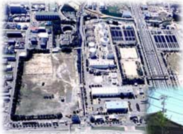
中央浄化センター
