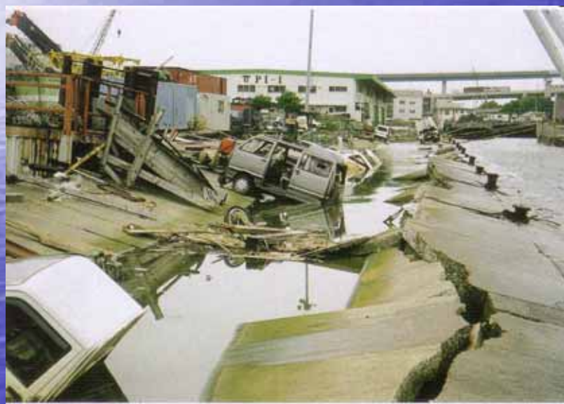
岸壁の倒壊、岸壁背後の液状化状況
