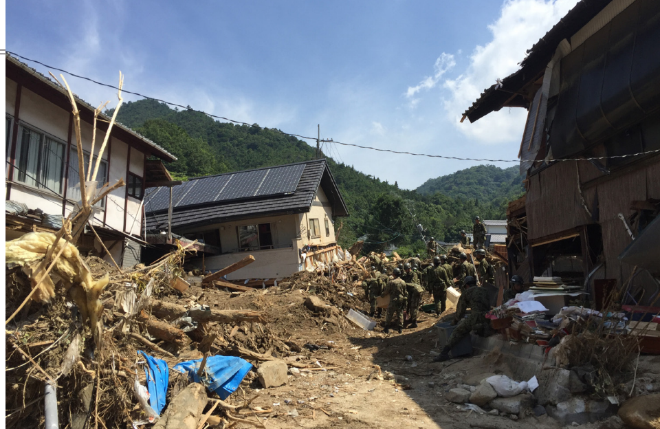
豪雨災害の被災状況（天応地区）
