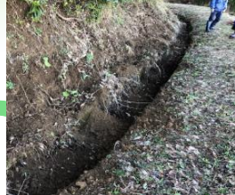
イノシシの掘り起こしによるのり面の崩壊
